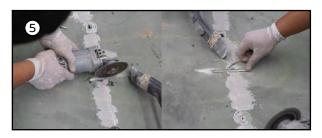
5) Grinding and embed Ferrostud 6 mm. space 20-30 cm.
