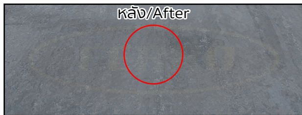
หลังเททับด้วย เฟอร์โรกรีต 217 แล้ว สังเกตรอยร้าวจะมีขนาดเล็กลง
